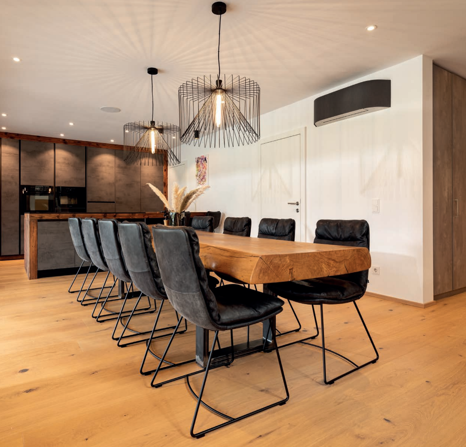
Magánlakás, Hasenbichler Kälte- und Klimatechnik
