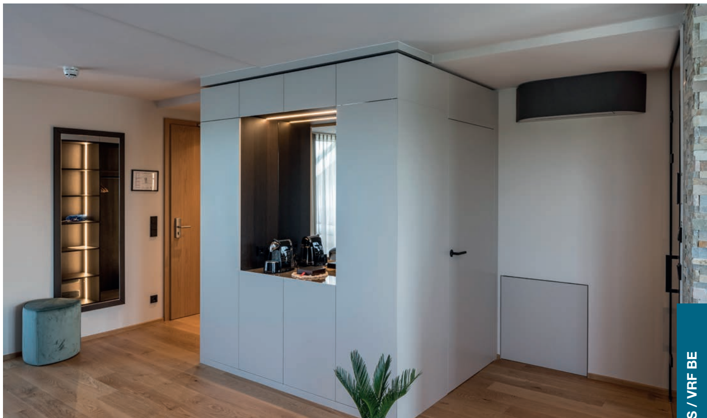
Hotel KOWALD Loipersdorf, PAMMER GesmbH Kälte-Klima-Technik
